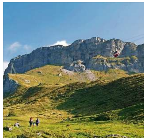
Die alte Cassonsbahn soll nun weichen.
