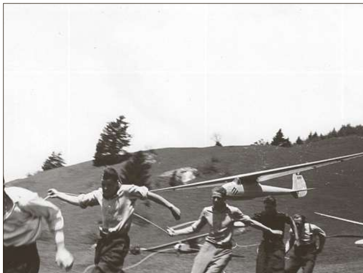
Die «Gummihunde» haben den Spyr III HB-109 soeben mit dem Startseil in die Luft katapultiert.
