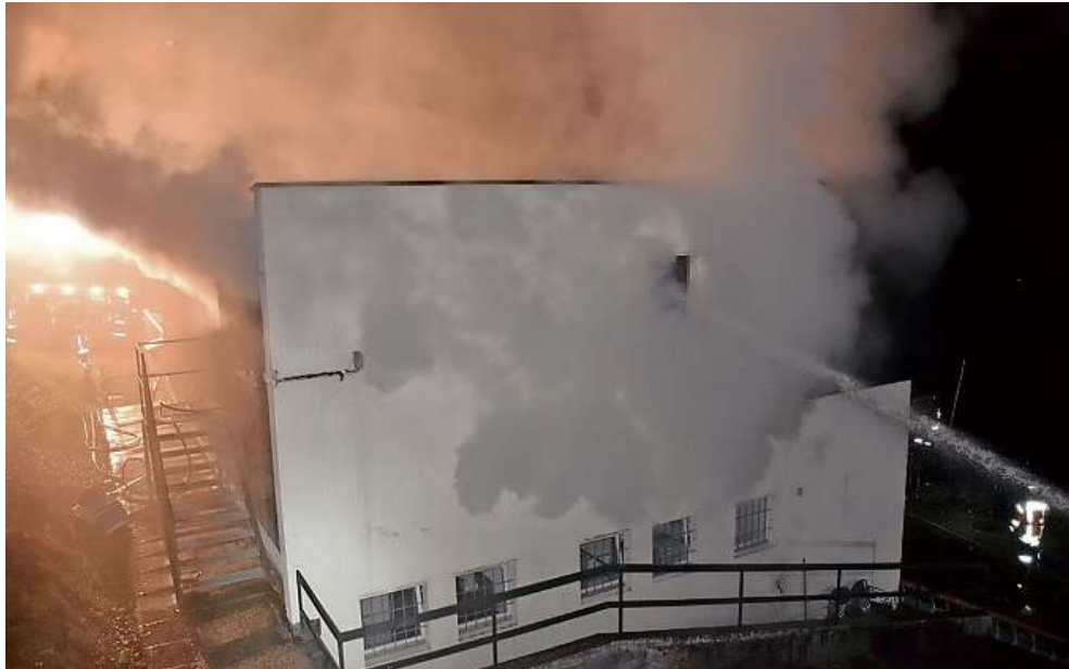
Der Brand im Restaurant am Caumasee ist glimpflich abgelaufen, das Restaurant kann trotzdem eröffnet werden. Pressebilder
